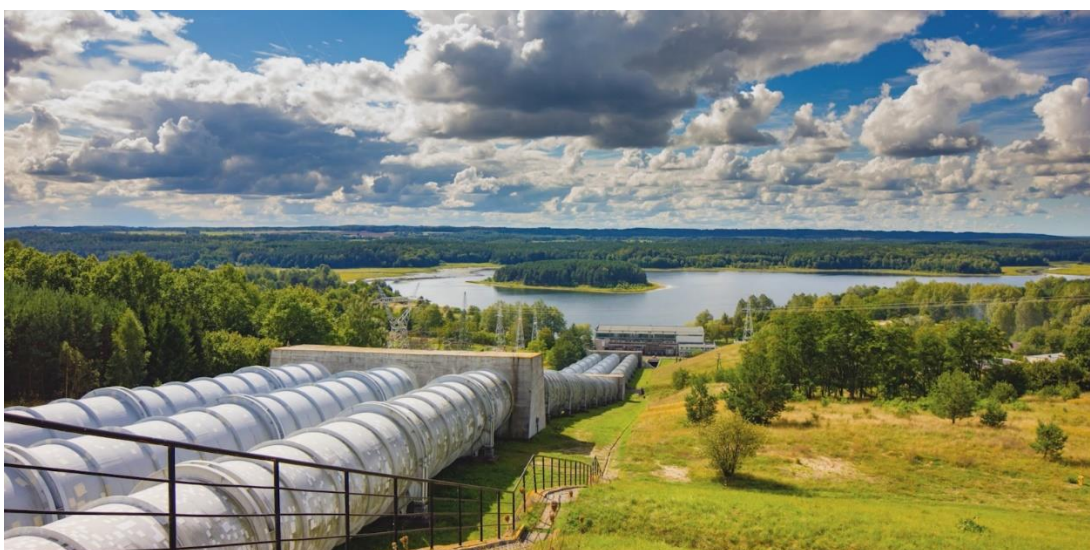
Fot. Nr 9. Gmina Polanów Jezioro Kwiecko - elektrownia w Żydowie
